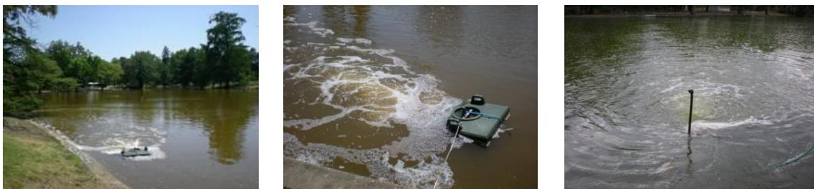
Figure 4. Différentes vues des aérateurs immergés dans le bassin.
