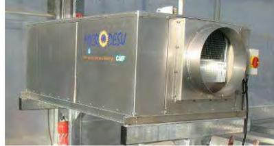
Figures 2 et 3 : Serre Venlo Optim'Air et déshumidificateur Microdesu
