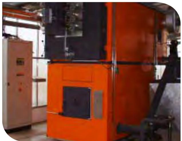
Photo 6 : Chaudière à bois Schmid (CH), puissance 450 kw
