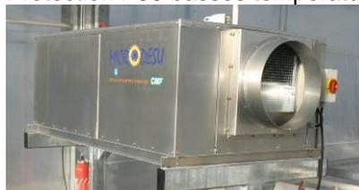
Figures 2 et 3 : Serre Venlo Optim’Air et déshumidificateur Microdesu fonctionnant pour des températures minimales allant jusqu’à 3°C
