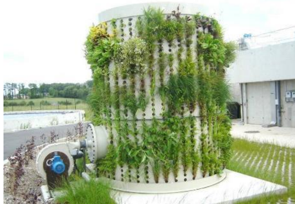
Photo de la tour à vocation phytoépuration de la station d'épuration de Fauville-en-Caux
