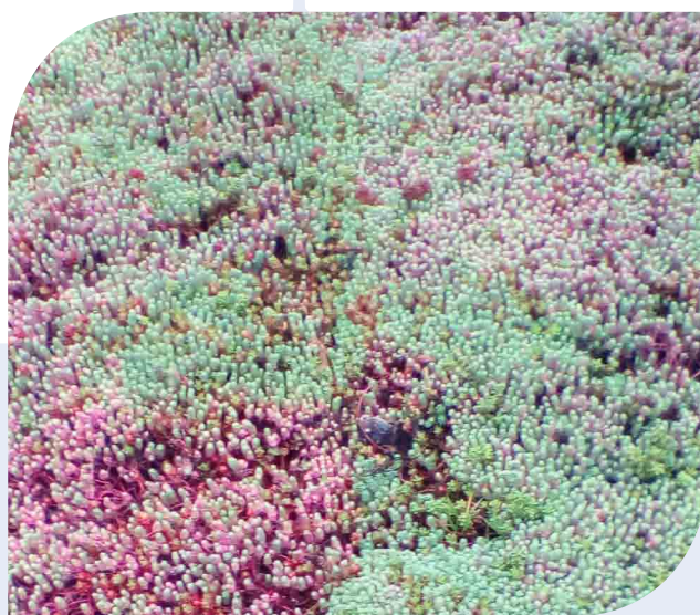
LE SEDUM, ESPÈCE COURAMMENT UTILISÉE DANS LA VÉGÉTALISATION DES TOITURES ● CRÉDIT PHOTO : ASTREDHOR/RATHO
